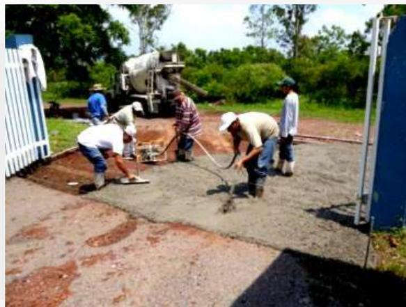
Rehabilitación y mantenimiento de la rampa de acceso al estacionamiento del Auditorio, por medio de piso de concreto hidráulico.
