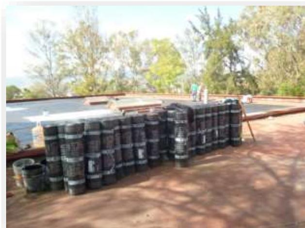
Impermeabilización por medio del sistema prefabricado en el edificio “B” Centro de Información, el cual es el más avanzado, confiable, higiénico y duradero que existe actualmente en el mercado. Con una inversión de \$320,000.0
